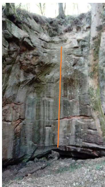
Partie centrale mal équipée
